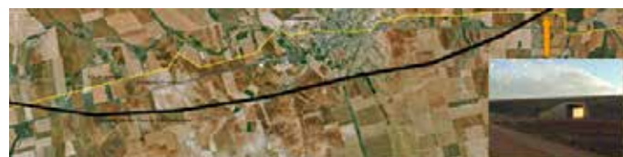
LAV en Montamarta. Paso inferior bajo la nueva línea AVE, a la altura del P.K. 256500 (28/08/2014)
