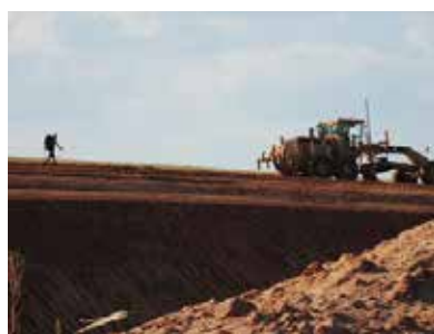
Un peregrino caminando junto a maquinaria pesada durante las obras de la A-66 (02/10/2014)
