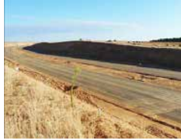
El Camino queda bruscamente cortado por la A-66. A la izquierda se ven los pilares del que será futuro P.S. Nº 10.5. (11/09/2014)
